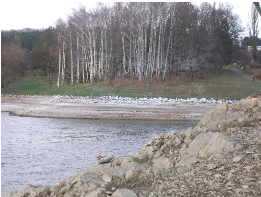
Povápněné břehy vypuštěné přehrady
